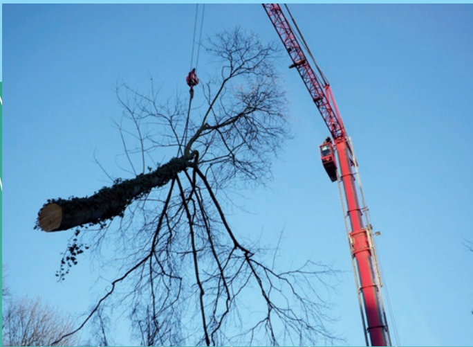
Fällen mit Mobilkran ▲
